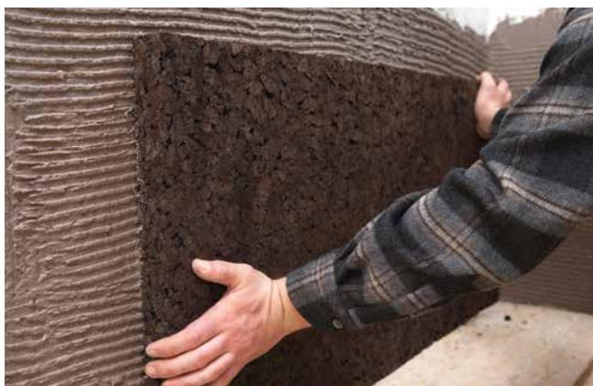
**Schritt 4:** Sattes Andrücken der Cellco® Korkdämm-Platte in den Cellco® Kork-Lehm-Klebemörtel, um eine homogene Ankopplung an die Außenwand zu erreichen.
