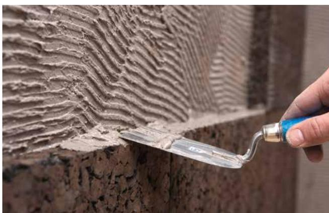
**Schritt 5:** Auftrag von Cellco® Kork-Lehm-Klebemörtel auf die Bereiche der Plattenstöße, um eine innige Verbindung zu erreichen und Wärmebrücken zu vermeiden.
