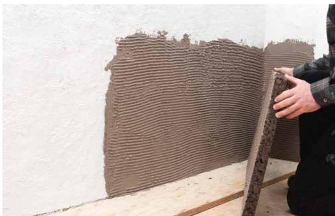
**Schritt 3:** Beim Ansetzen der Cellco Korkdämm-Platte in den Cellco® Kork-Lehm-Klebemörtel ist darauf zu achten, dass keine Schmutzteile oder andere Klumpen auf der ebenen Fläche vorhanden sind.
